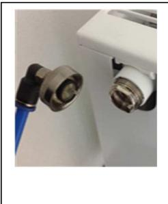
Zur schnellen und gründlichen Handentlüftung öffnen Sie bitte wieder den Vor-und Rücklauf des Heizkörpers und schrauben Sie den Entleerungsschlauch (Artikelnummer T2152) auf den im Heizkörper montierten Entlüfter.
