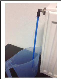
Während des Entlüftungsvorganges empfehlen wir das austretende Luft-Wassergemisch in einen dafür geeigneten Behälter abzuleiten.
