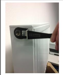
Montieren Sie der Körper den dauerhaften Entlüfter ECO (S-Vent Duo) in den Heizkörper, benutzen Sie hier für bitte den eigens dafür lieferbaren S-Vent DUO Montageschlüssel (Artikelnummer T2151), benutzen Sie auf gar keinen Fall eine Wasserpumpenzange o.ä.
