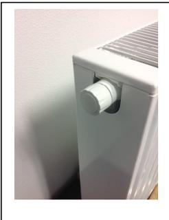
**Achtung :** Nach der Handentlüftung drehen Sie den Membrandeckel auf den Entlüfter, die permanente Entlüftung des Heizkörpers ist nun aktiviert.
