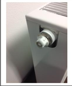
Demontieren Sie zuerst den werkseitig vormontierten Entlüftungsstopfen.
